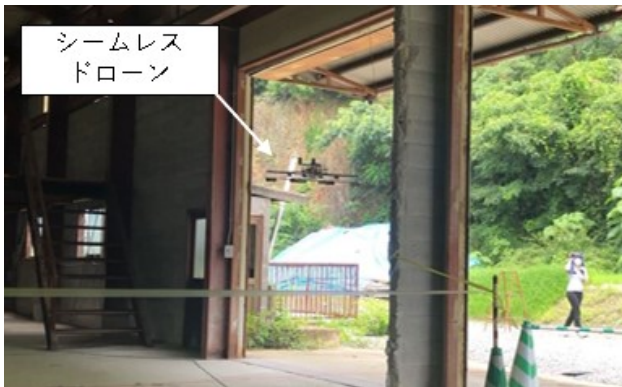
写真 1 進入時の様子
